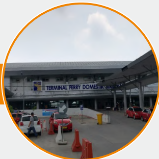
Terminal Ferry Domestik Sekupang
